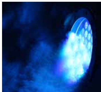
Abb.: Es kommen LED-Scheinwerfer in verschiedenen Baugrößen zum Einsatz. Sie sind mit RGB-LEDs bestückt oder bieten Tuneable-White-Funktion. Für das Dimmen und die Farbwechsel sind die Strahler bei diesem Projekt an eine DMX-Lichtsteuerung angeschlossen. Mit hoher Schutzart und Gehäusen aus Edelstahl trotzen sie Schnee und Eis. (Foto: Wibre)
